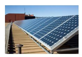
Les panneaux solaires photovoltaïques permettent d'alimenter un bâtiment en électricité. Ces panneaux sont généralement installés sur le toit d'un bâtiment ou d'une autre structure en extérieur. Les panneaux photovoltaïques produisent de l'électricité en convertissant l'énergie solaire en courant continu. Pour en savoir plus sur les panneaux photovoltaïques, cliquez ici.
