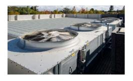
Certains systèmes CVC (chauffage, ventilation et climatisation) sont équipés d'une tour de refroidissement (généralement située sur le toit) permettant de rejeter la chaleur superflue pendant l'été. Les tours de refroidissement consomment de grandes quantités d'électricité et d'eau. L'entretien et l'optimisation de leurs performances est donc particulièrement important.
